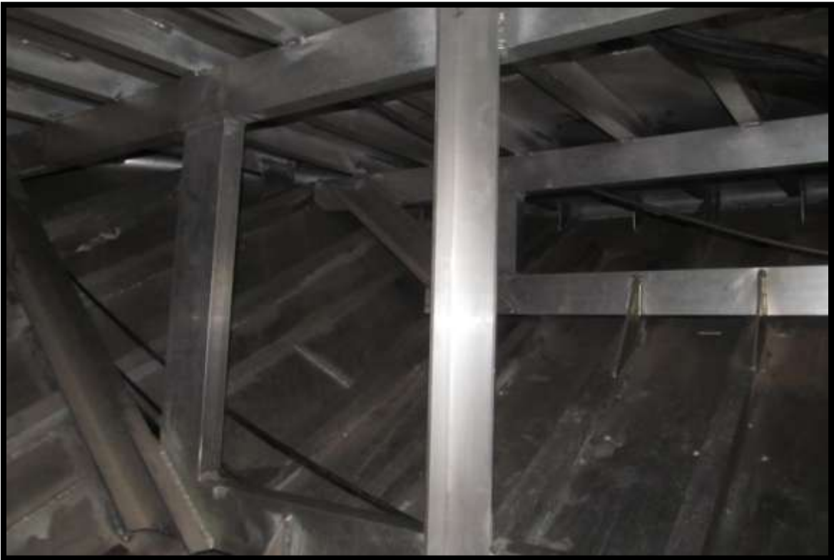
BARGE HULL SIDE STRUCTUE
